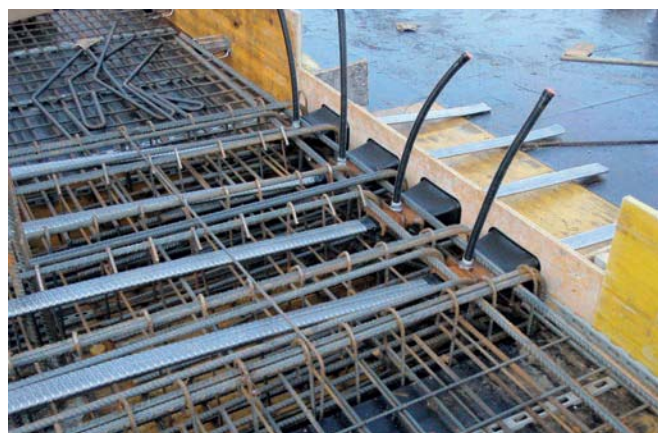
Plochá kotva pro stropní desky
