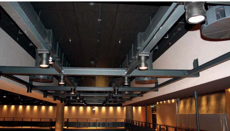
Pohled na ocelový rošt „Rigging“ – detail
