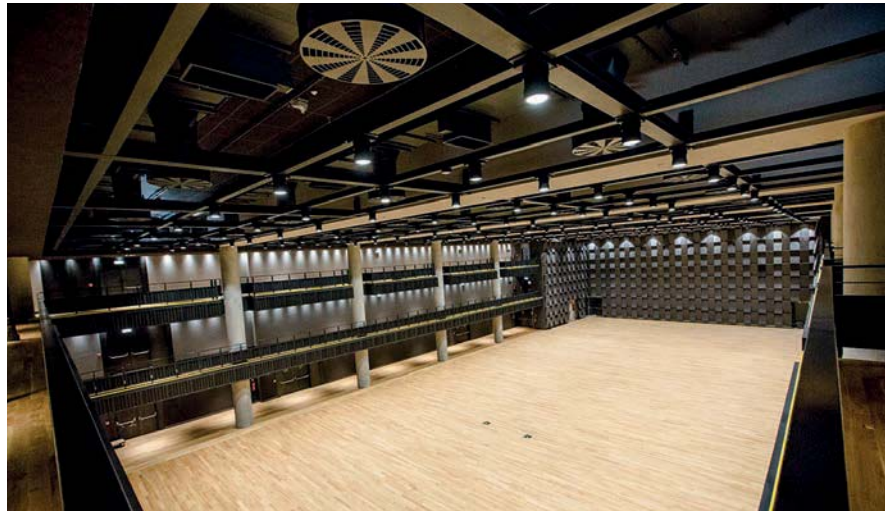
Obr. 1 – Pohled do sálu, ocelová konstrukce Riggingu (horní část) a akustická stěna jeviště (v zadní části).
