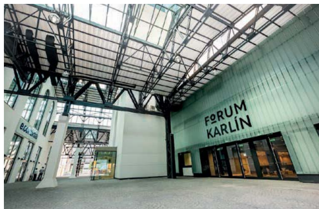
Obr. 3 – Napojení původní ocelové nýtované příhradové konstrukce na novostavbu Fora Karlín
