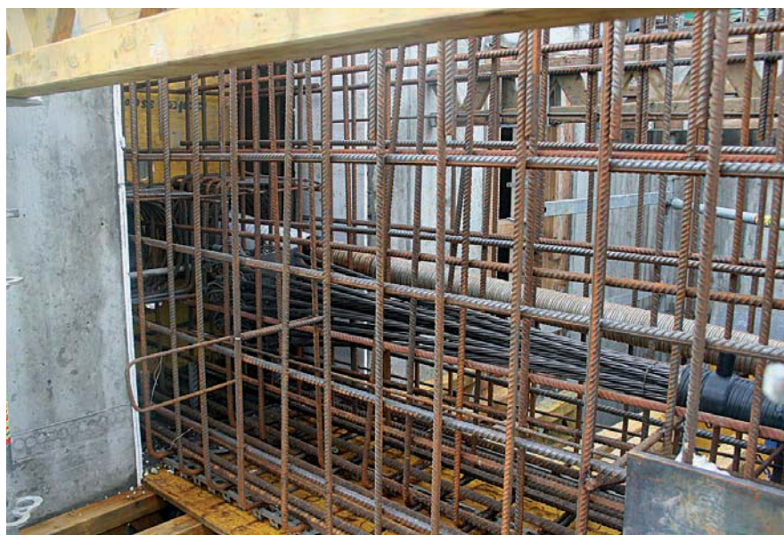
Osazená aktivní a pasivní („cibulová“) kotva v bednění trámy
