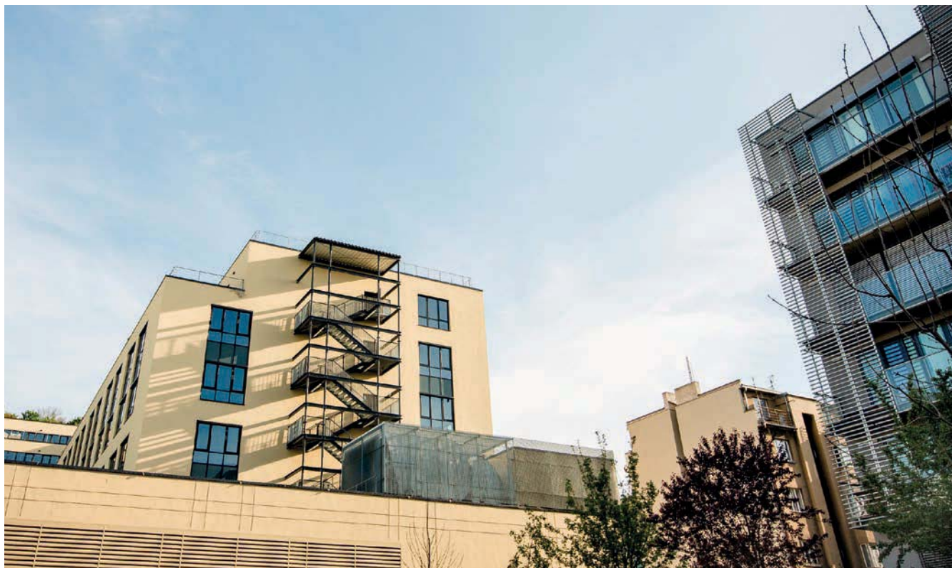
Obr. 2 – Únikové schodiště na severní straně objektu, v popředí konstrukce opláštěná fasádním systémem z porořostů
