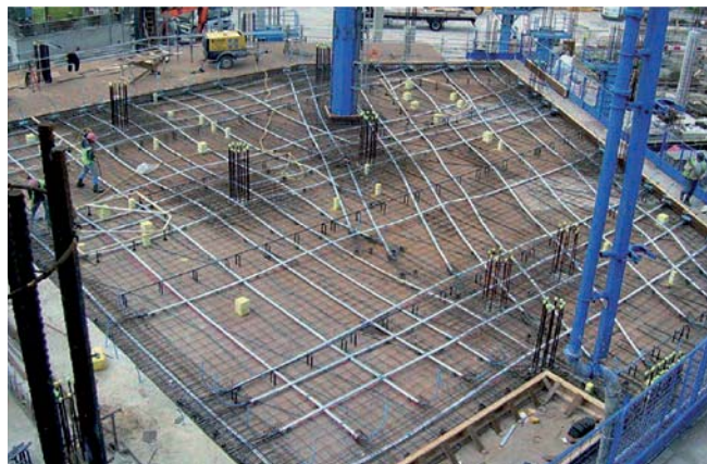
Předpjatá stropní deska
